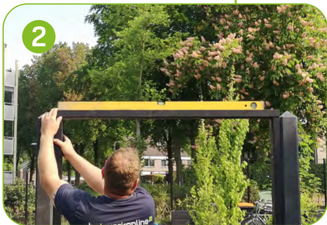
Tweede kozijndeel tegen paal plaatsen.
